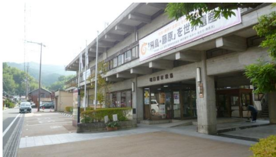
フラットな屋根の形態、コンクリート打ち放しの外壁仕上げ、バルコニー、階数（西庁舎は3階建て）は、現在の明日香村景観条例（平成23年）の基準に適合していない。
