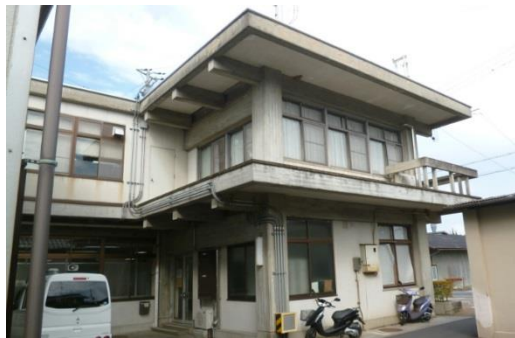
外壁に設備配管が露出（本庁舎）
