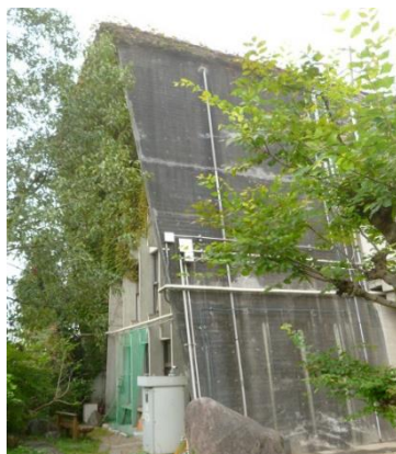
外壁に設備配管が露出（本庁舎）
