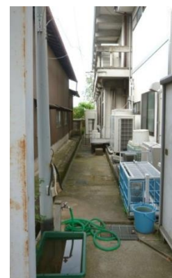
庁舎と隣地の民家の隙間に設備機器や倉庫が置かれている
